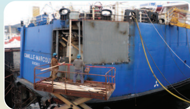
Le N.M. Camille-Marcoux en cale sèche, au chantier naval Verreault Navigation à Les Méchins
