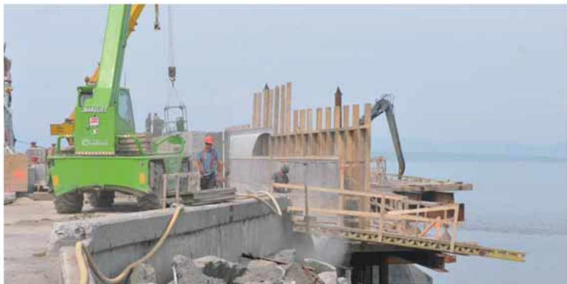
Travaux au quai de la traverse de Rivière-du-Loup.
